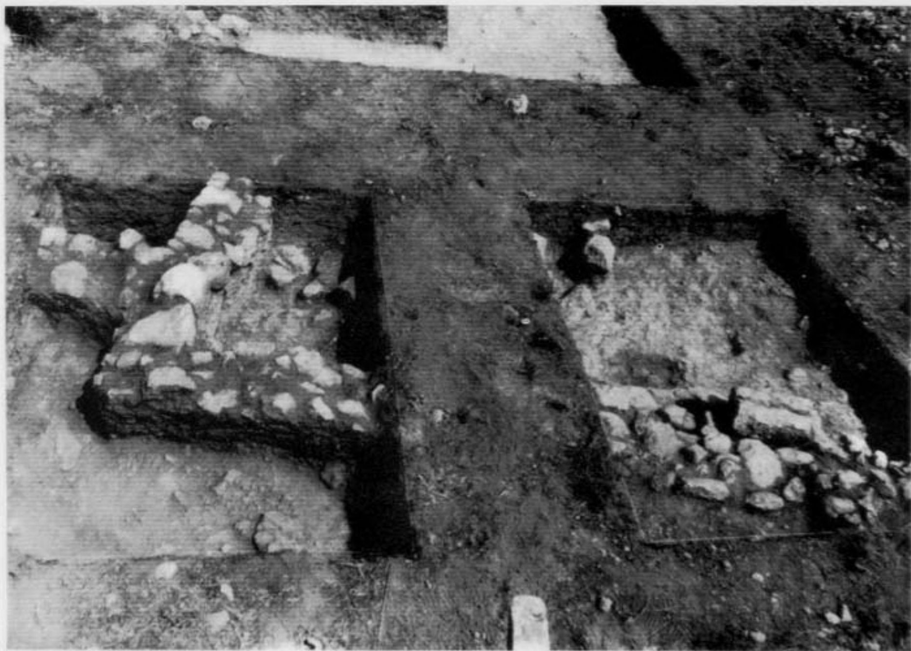
2. Base del muro. Cata 4.
